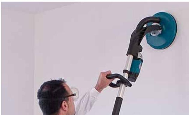
La durabilidad de un recubrimiento depende siempre de la buena preparación de la superficie, curado del soporte base, desengrasado y limpieza. En función del estado inicial del soporte es vital hacer un tratamiento previo adecuado antes de aplicar la capa de imprimación para garantizar una buena adherencia.
